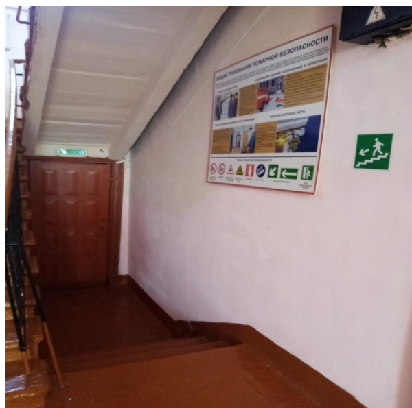
Фото 9. Пути эвакуации 1 этаж
