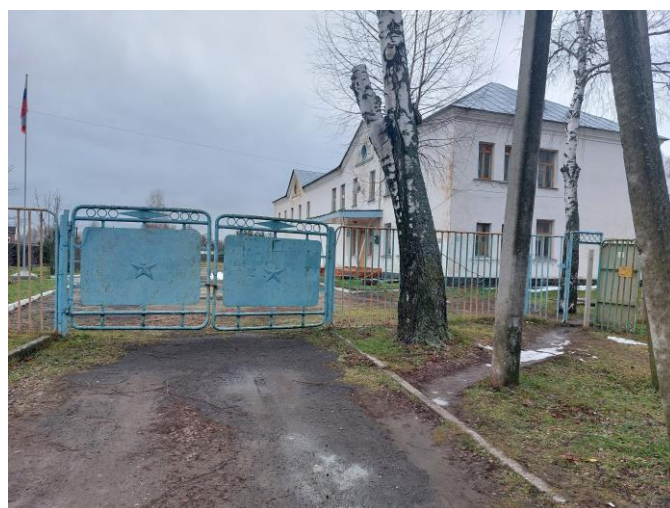
Фото 2. Вход (въезд) на территорию
