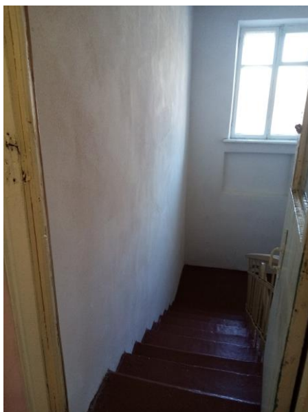
Фото 10. Пути эвакуации 2 этаж
