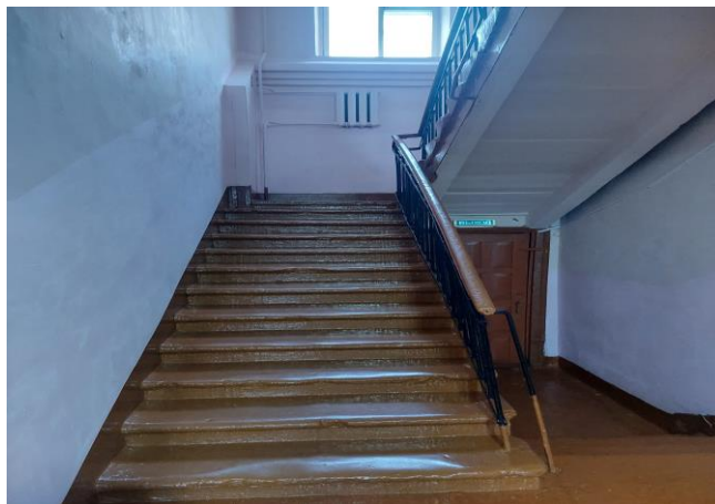
Фото 8. Лестница (внутри здания)
