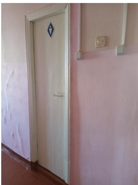
Фото 12. Вход в туалетную комнату
