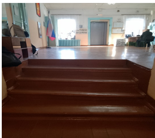
Фото 8. Лестница (внутри здания)
