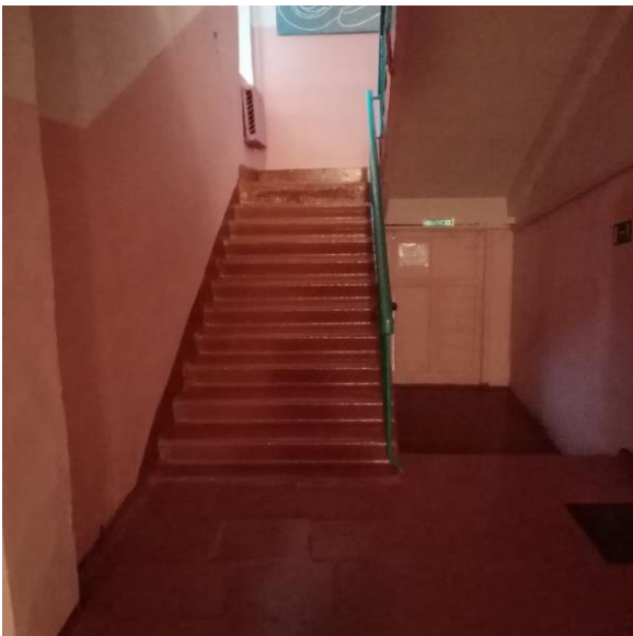
Фото 8. Лестница (внутри здания)
