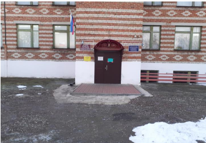
Фото 5. Вход в здание
