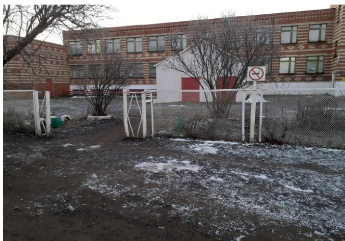
Фото 1. Вход на территорию
